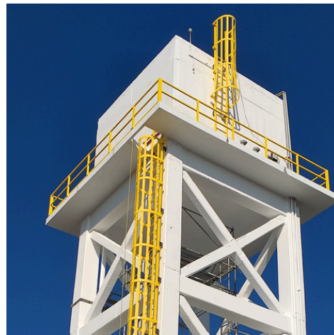
TANQUE ELEVADO No. 1
