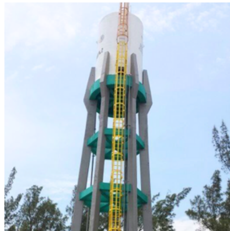
TANQUE ELEVADO 23M No. 2
